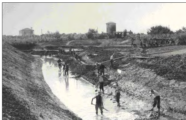
Fig. 5 - Una foto delle opere di bonifica; iniziate nel 1828, le bonifiche della Maremma fecero aumentare notevolmente le terre coltivabili e la salubrità delle coste, di conseguenza in tutta la zona si registrò un forte incremento demografico.
